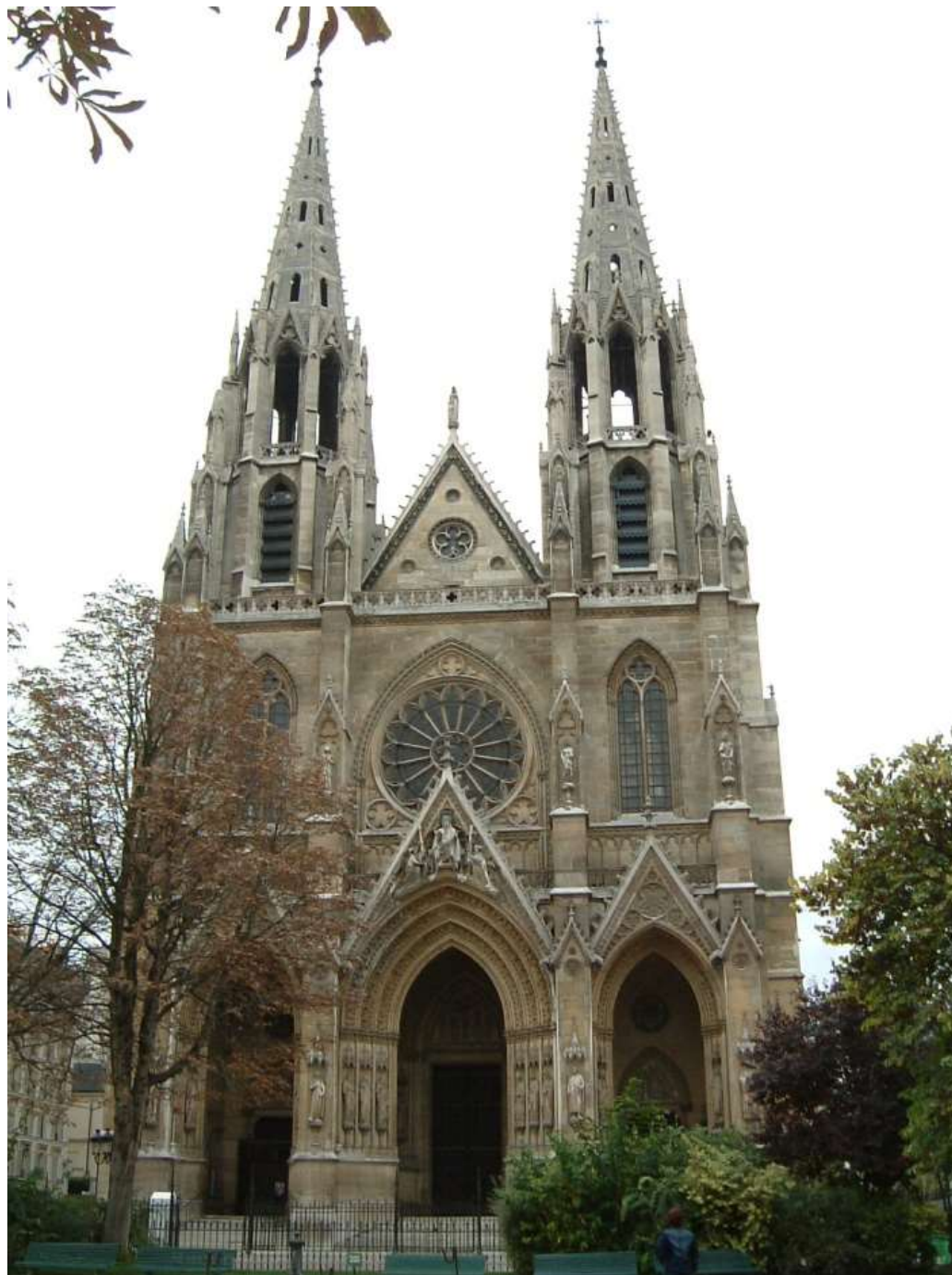
Figura 8 – Igreja de Sainte-Clothilde, Paris. Construção em estilo Neogótico finalizada em 1857.
