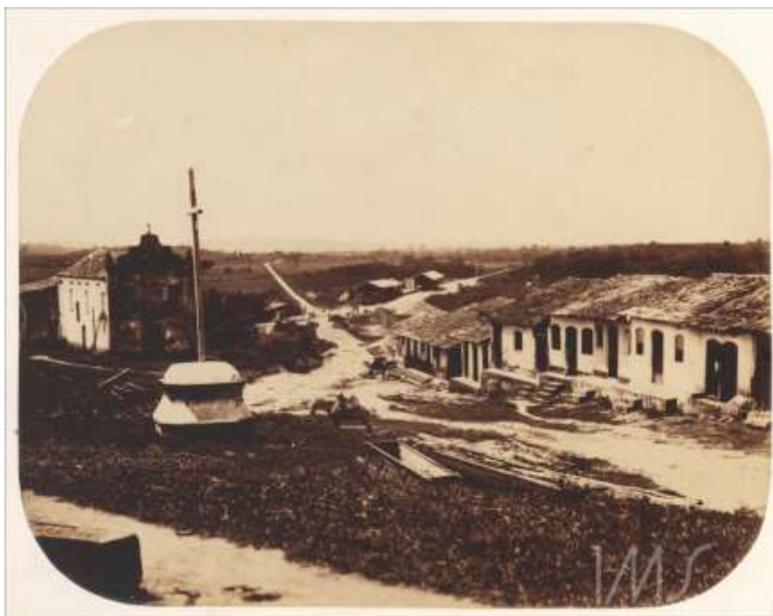
Figura 79 – Casario em tipologia colonial na Vila do Cabo, c. 1858.
