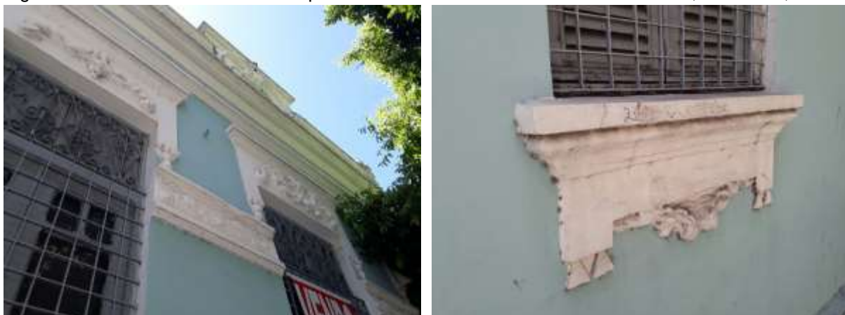
Figuras 57 e 58 – Relevos em estuque na casa nº 899 da Avenida Manoel Borba, Boa Vista, Recife.
