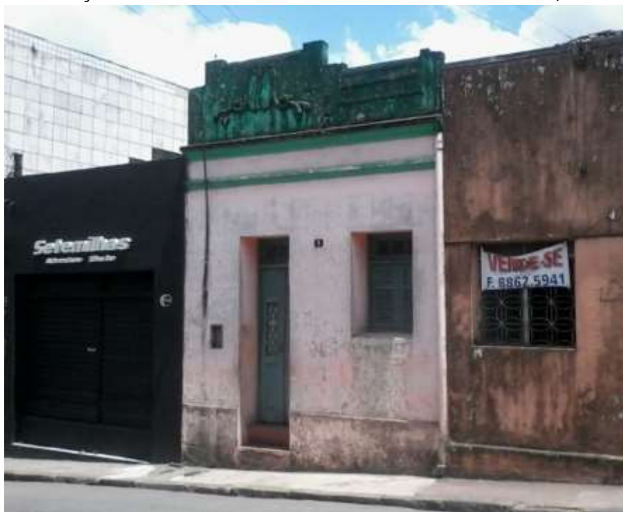
Figura 96 –Edificação situada no número 8 da Rua Visconde de Pelotas, Centro do Cabo.
