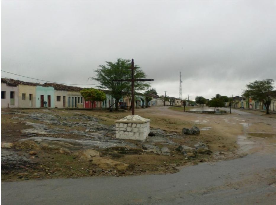
Foto 22 – Vista atual da Praça de Cimbres
