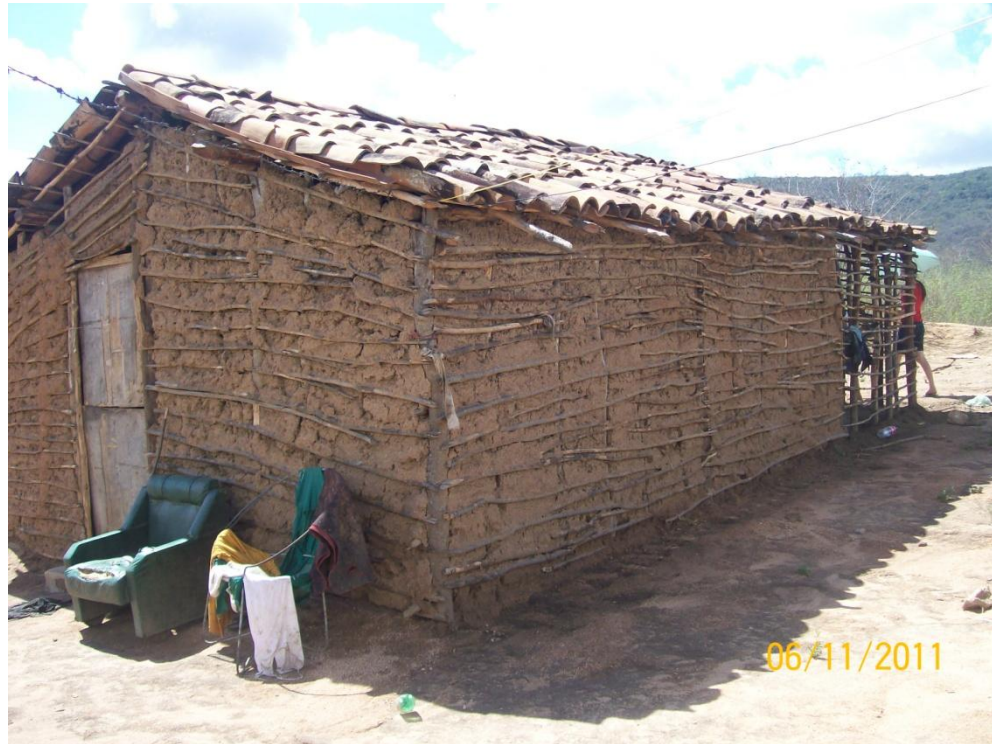
Foto 14 - Fachada de uma moradia feita de barro e madeira na comunidade quilombola do sítio Caldeirão
