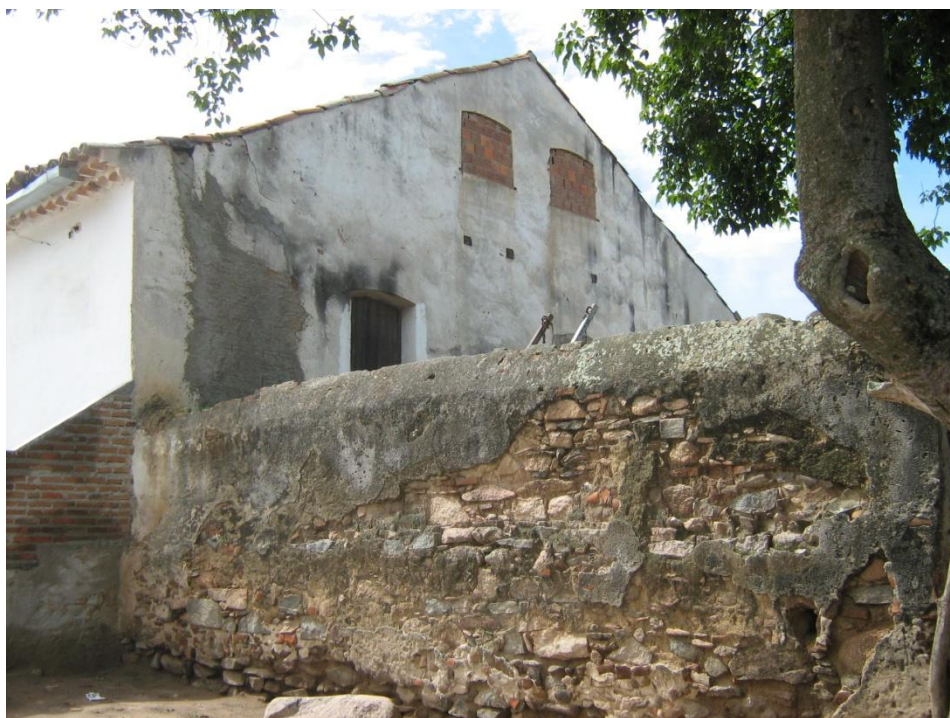
Foto 34 – Vista lateral do casarão do sítio Santa Rosa
