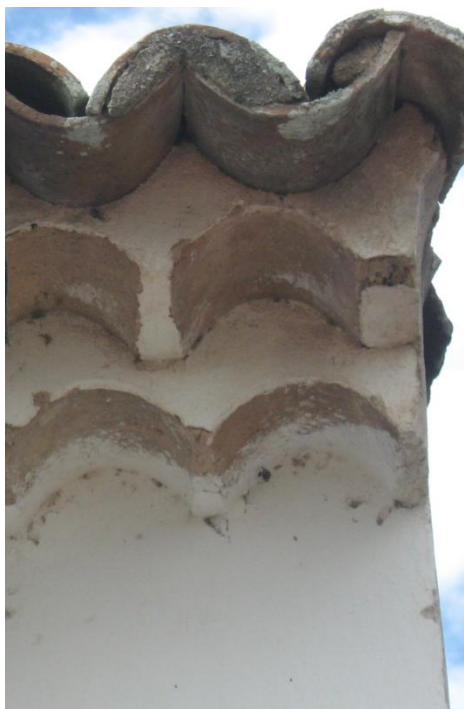
Foto 36 - Detalhe da tríplice telha
